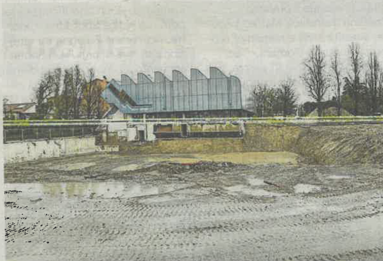
Demolito l'ex centro sportivo Cierrebi di via Marzabotto, sarà ricostruito
