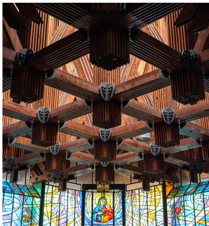
Le capriate del soffitto della chiesa di San Pio X
