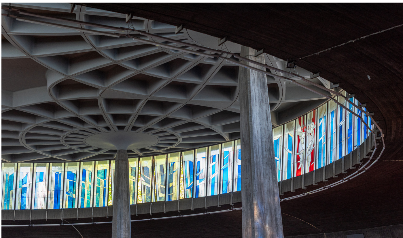
La copertura in cemento progettata da Pier Luigi Nervi all'interno della chiesa del Cuore Immacolato di Maria
