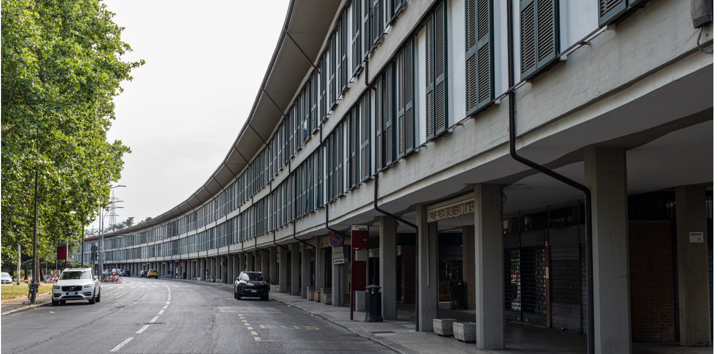
Il celebre edificio del “Treno” in via Tommaseo nel quartiere Barca (tutte le foto sono di Paolo Tomasi)
